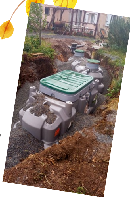
Changement de fosse septique du logement de l'ancien four à chaux
